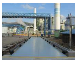
플랜트 기업 트럭스케일 설치사례
